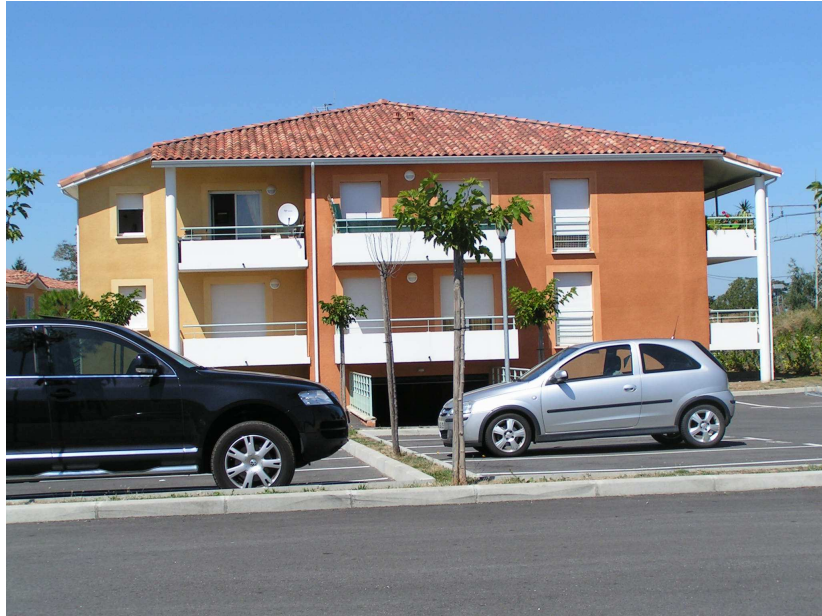
Vue d'ensemble du parking aérien et du Bâtiment C.
